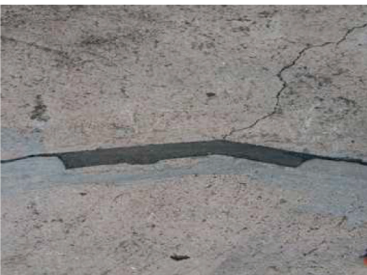
รูปที่ 8 เก็บข้อมูลด้วยภาพถ่ายของจีโอโพลิเมอร์มอร์ตาร์ผสมเถ้าหนัก
