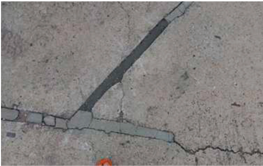
รูปที่ 7 เก็บข้อมูลด้วยภาพถ่ายของจีโอโพลิเมอร์มอร์ตาร์ผสมเถ้าหนัก
